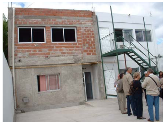
Die neuen Klassenräume sind im Rohbau fertig
